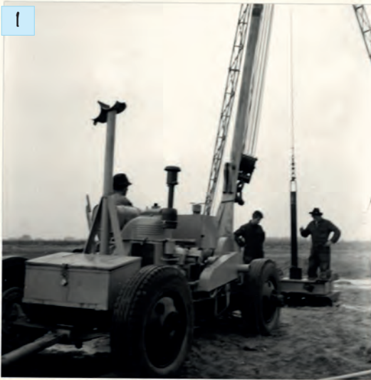
1 De diepe boring Ouwerkerk (tot 156 m) door Grondboorbedrijf H. Haitjema & Zn. uit Dedemsvaart, oktober-november 1962. Boormeester Mies Baas. Foto afdelingshoofd W.A. van Eijden
