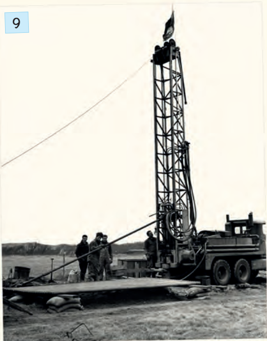
Spoelboorinstallatie op Vliegveld Haamstede. Links Martin Cadée die op bezoek was, Ton Schlepers, 3e van links ben ik, rechts de boormeester, Arend Tholen. De vlag is vanwege de locatie op het vliegveld. Foto Rijkswaterstaat, 15-1-1969.
