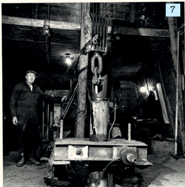
Zwaar hijswerk in de houten boorkeet van de boring in foto 6. Aan de lier Jan Baas. Foto Rijkswaterstaat, 21-4-1965.
