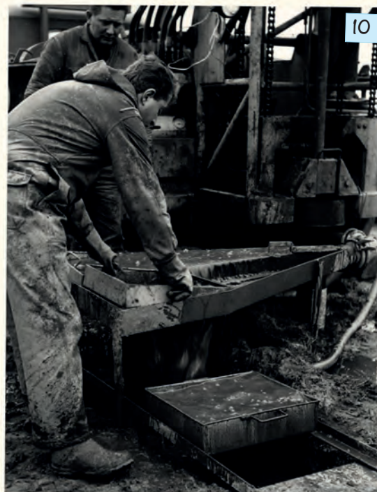
Monsternamen op een spoelboring op Vliegveld Haamstede. Ik zet hier een schoon monsterbakje in het frame, op achtergrond Arend Tholen. Foto Rijkswaterstaat, 15-1-1969.
