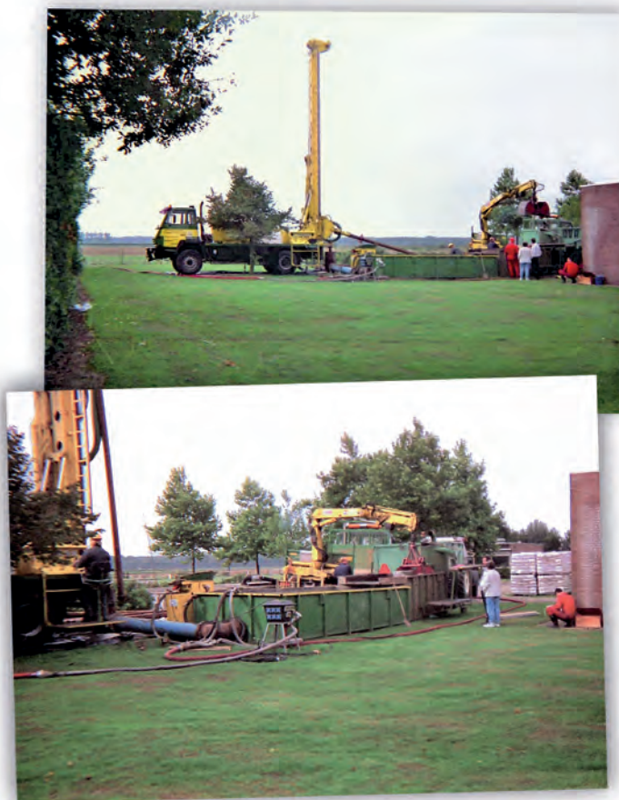
1a/b. Archieffoto's van een van de rotary luchtliftboringen in Zeeuws-Vlaanderen. Foto's: Ko de Vos
